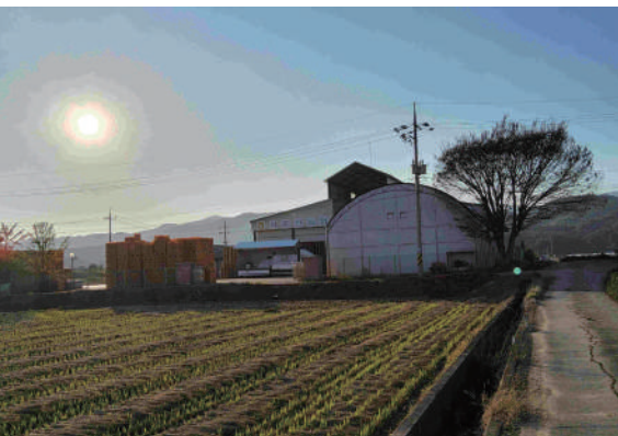
서춘천 농협 저장고 전경
