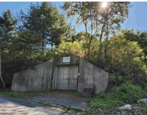
여량리의 감자유통시설 전경
